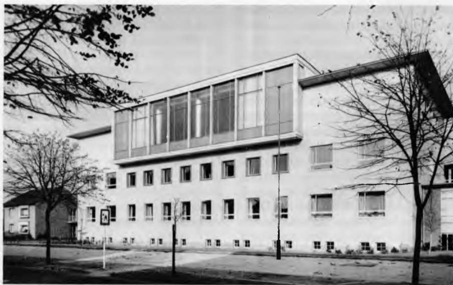
Der umgebaute Altbau an der Bochumer Straße
